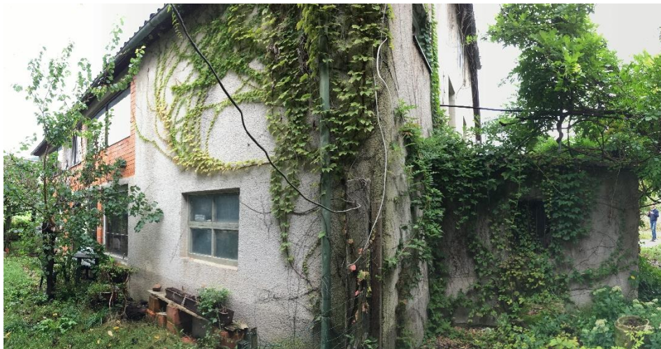
Slika 5: Stanovanjski objekt, pogled od zadaj
